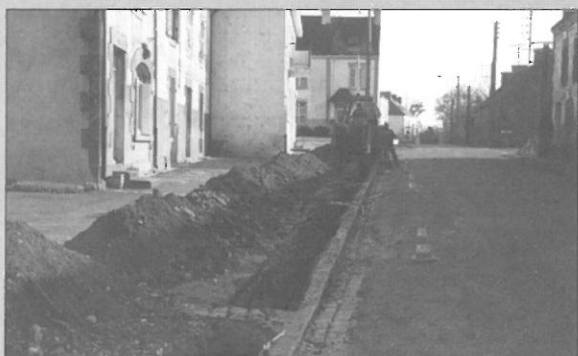
Extension du réseau à Bécherel
