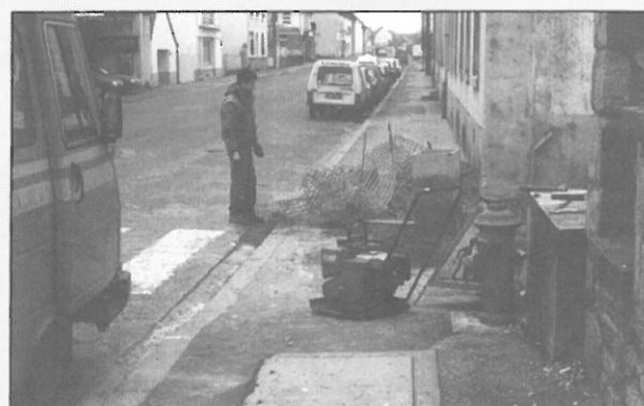
Rue Paul Ihuel - Rue du Patronage eaux pluviales- le coût : 55.000,00 F
