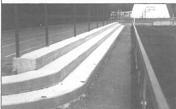
Construction de gradins
