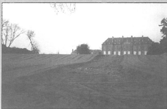
Mise en forme de la terre végétale
