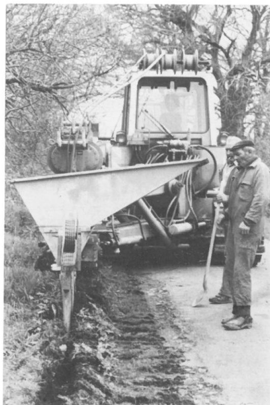
ROUTE DE LANVAUDAN : pose d'un nouveau câble de télécommunication
