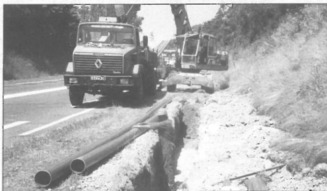
ASSAINISSEMENT Une canalisation directe entre Restavy et Pont en Daul par la déviation.
