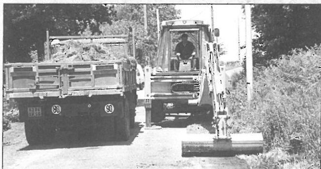
L'arasement d'accotements (ici à Kergant).
