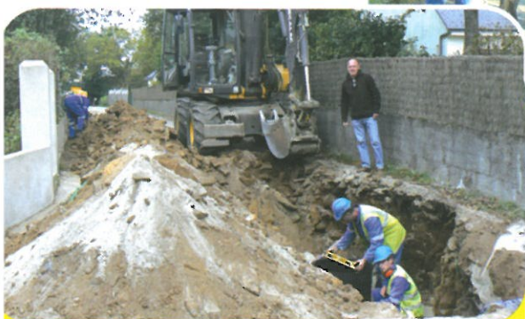
Octobre 2007 : Début des travaux
